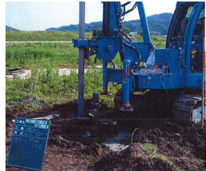
写真1 地盤改良柱の施工
