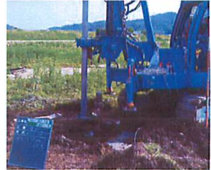
写真1 地盤改良柱の施工
