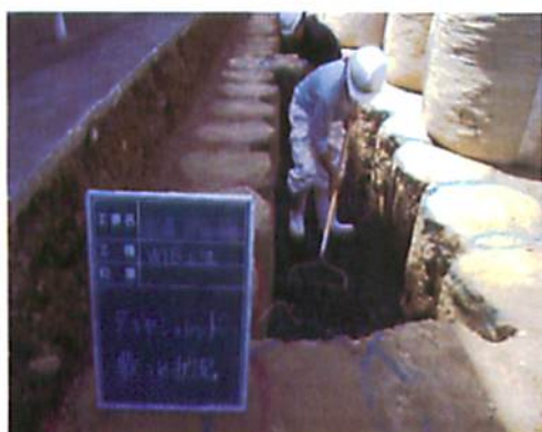
破砕した廃タイヤを主体とする振動減衰材を敷き詰めている様子 (写真・資料 E&Dテクノデザイン)
