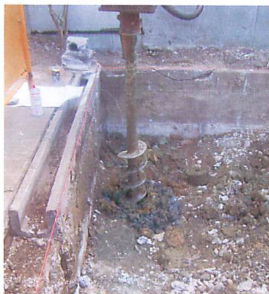
(1) H鋼建込み用掘削
