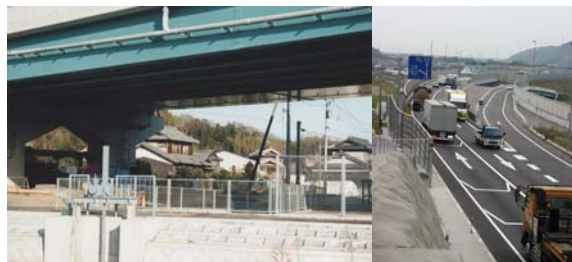
写真-2 高架道路周辺住家
