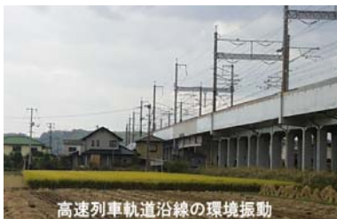
写真-1 高架鉄道沿線住家
