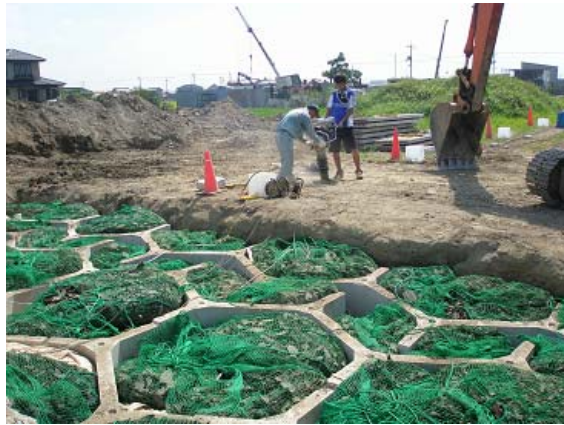
ランマー加振状況
