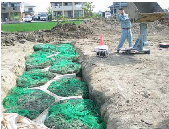
水平加振状況 (面内方向)
