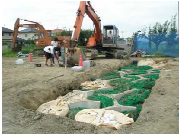
水平加振状況（面内方向）
