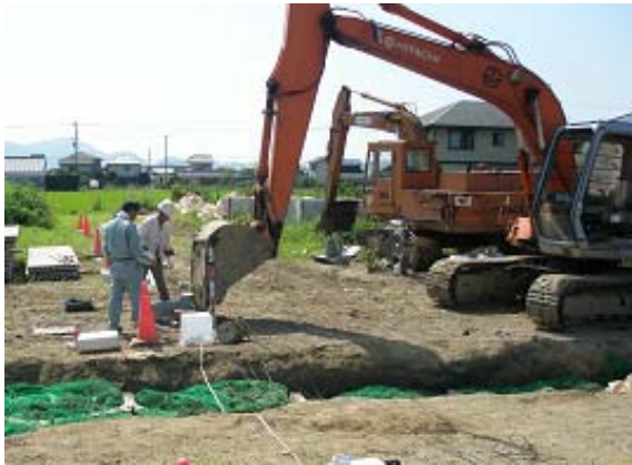
ガイドハンマーによる鉛直加振状況
