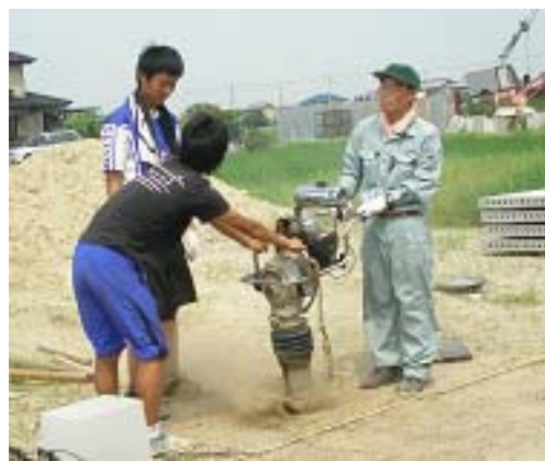
ランマー加振状況
