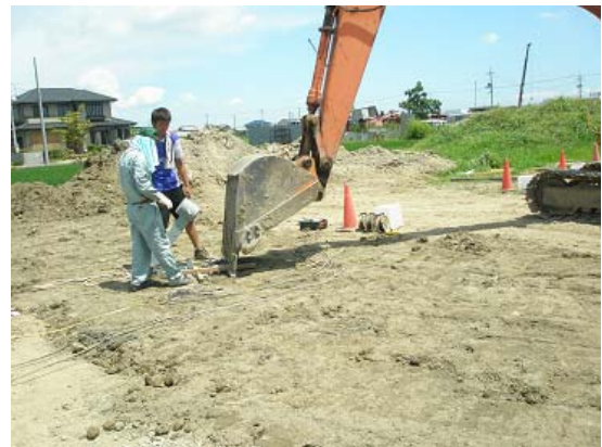
図 1 4 ハニカムとパネル WIB 上へ土被り
