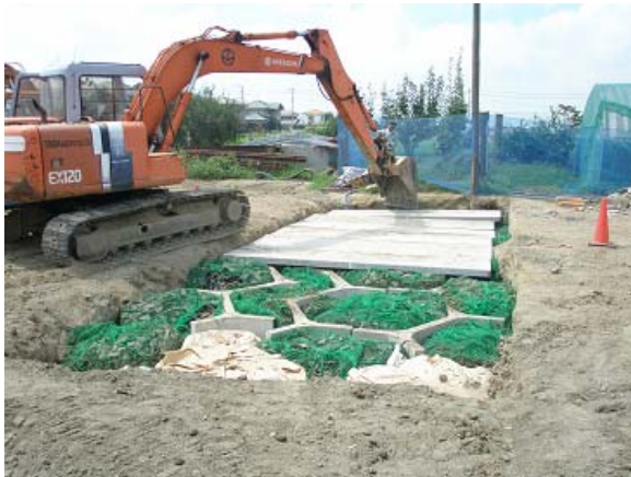
図 1 4 ハニカムとパネル WIB 上へ土被り
