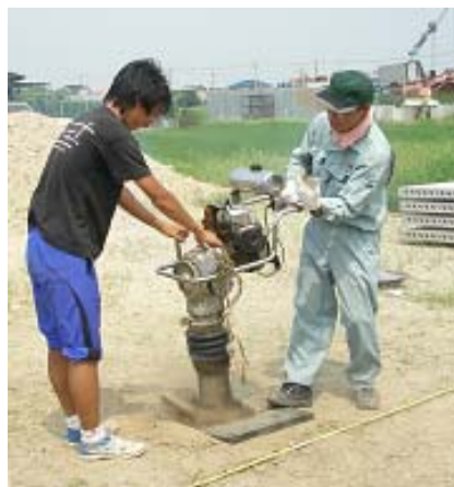
(d) ランマーの稼動
