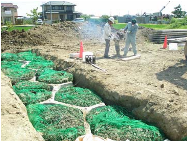
ランマー加振状況
