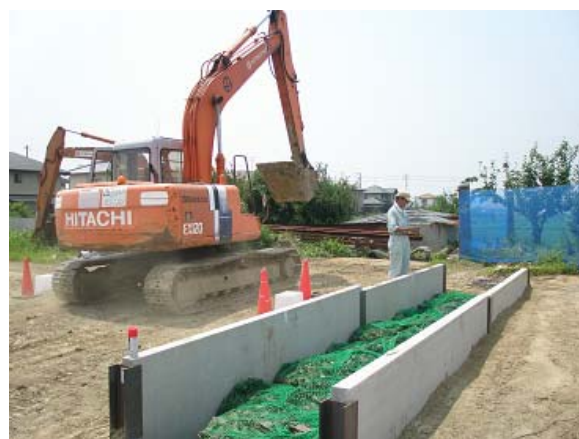
バックホー走行加振状況
