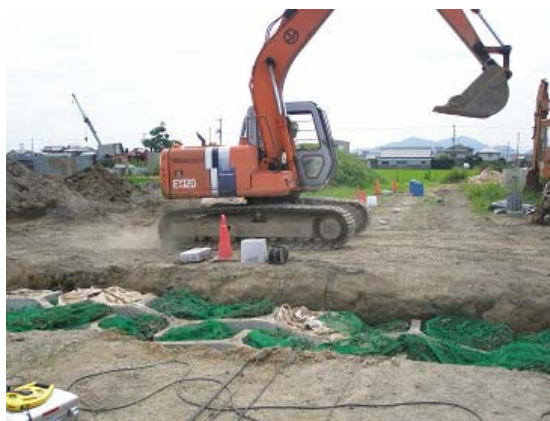
バックホー走行加振状況
