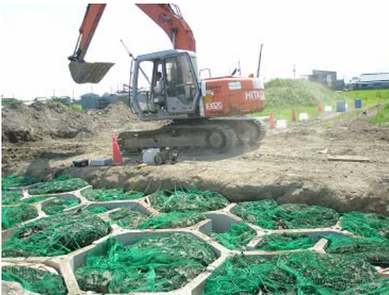
バックホー走行加振状況
