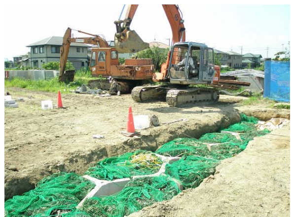
バックホー走行加振状況
