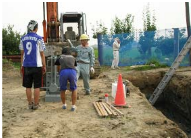
水平加振状況（面外方向）
