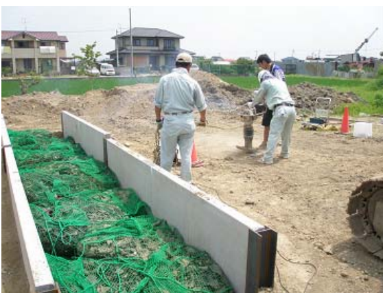
ランマー加振状況
