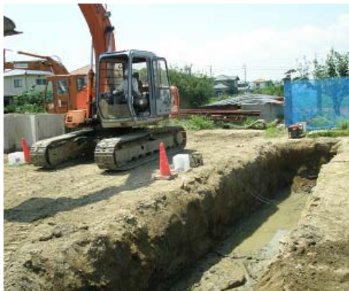
バックホー走行加振状況
