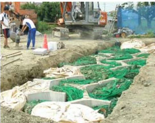
ランマー加振状況
