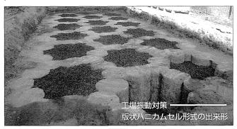
WIB工法とは、地中の所要深さに、地盤改良杭による剛性の高い版状あるいは壁状のセル形式構造体(WIB工)を構築して、環境振動や地震時の構造物への地震作用力を低減する振動対策工法です。
