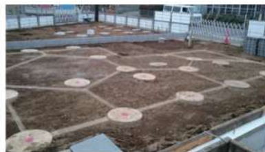
WIB工の施工状況 (A棟)
