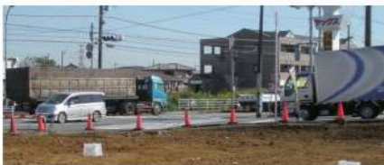
大型車が通過する医療施設建設地
