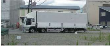
大型車が通過する工場建設地
