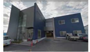
竣工後の精密加工工場
