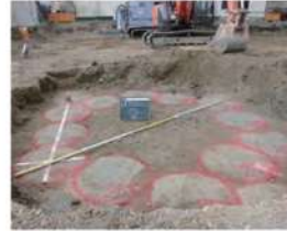
WIB工の施工状況
