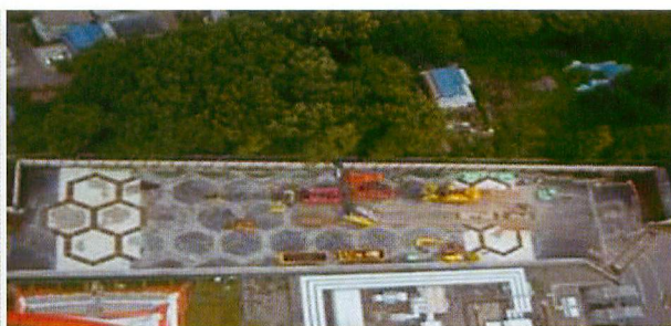
都内事業所からの振動遮断WIB工事
