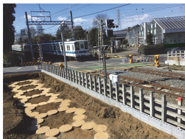
建物と振動源の間にWIB工法を施工
