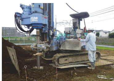
建物下部へWIB工法を施工
